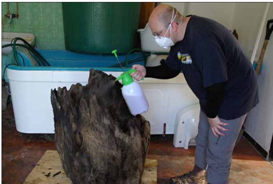
Konzervace dutého kmene určeného pro jímání minerálního pramene.
